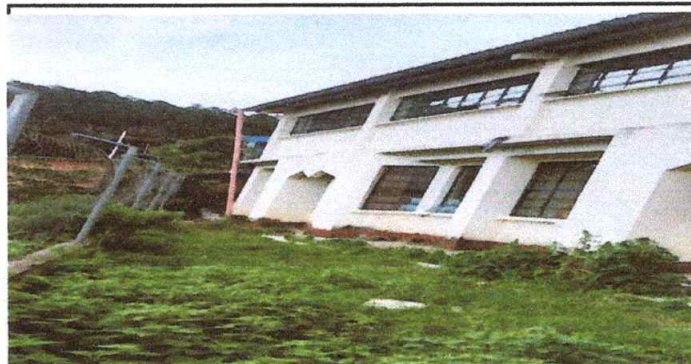
Foto 10: Sustitución de balcones de metal
