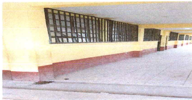
Foto 7: Sustitución de balcones de metal
