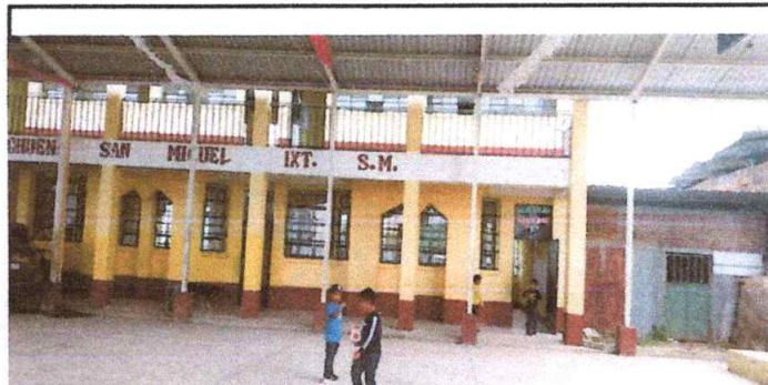
Foto 4: Pintura en muros exteriores e interiores
