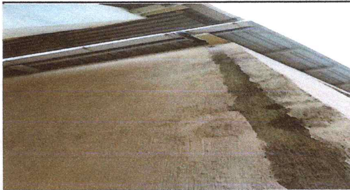
Foto 2: Sustrucción de bajada de agua pluvial de metal por pvc 3"
