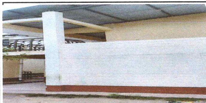
Foto 3: Pintura en muros exteriores e interiores
