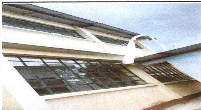
Foto 1: Sustrucción de canal de pvc
