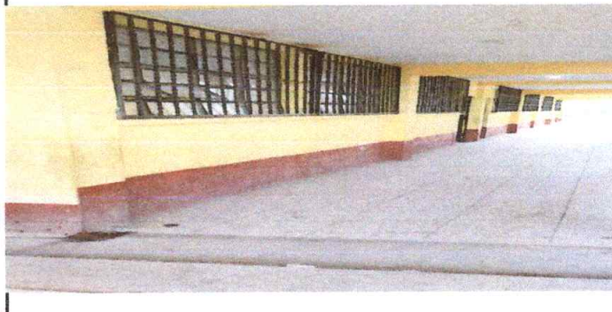
Foto 8: Sustitución de alcones de metal
