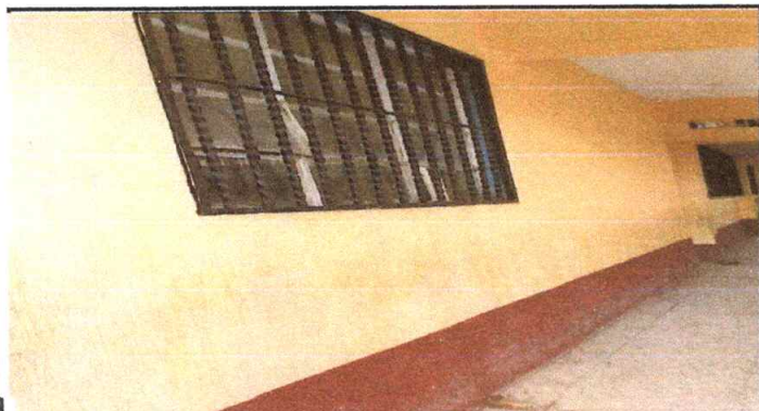
Foto 9: Sustitucion de balcones de metal
